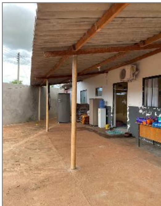
Figura 32 - Área de Circulação, Sede da ONG ADAPV
