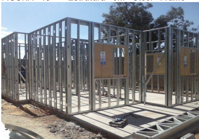
FIGURA 19 - Estrutura em Steel Frame
