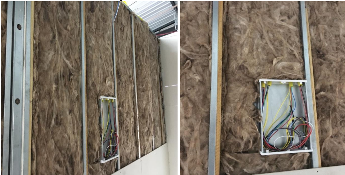
FIGURA 9 e 10 - Parede de Drywall com revestimento
