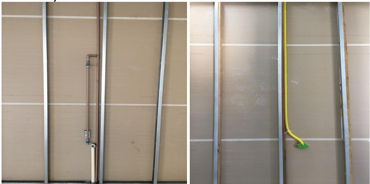
FIGURA 12 e 13 - Parede de drywall com pré instalações (elétricas e hidráulicas)
