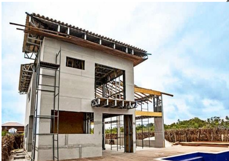
FIGURA 20 - Estrutura em Steel Frame com vedação
