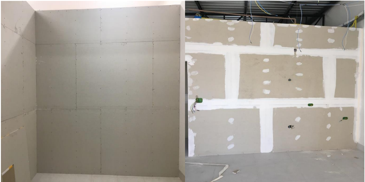
FIGURA 17 e 18 - Desperdícios gerados pela instalação de drywall
