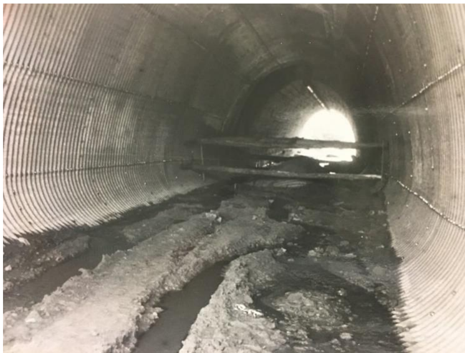
FIGURA 05 – Canalização do córrego
