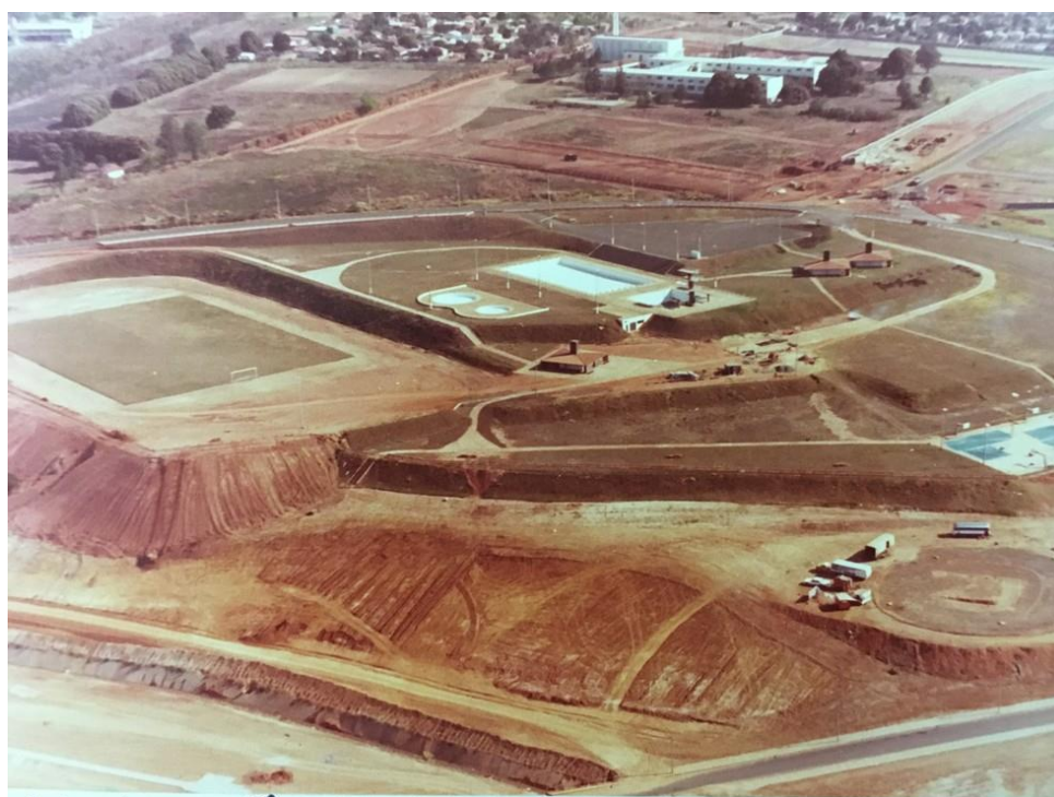
FIGURA 03 – Construção do Centro Olímpico
