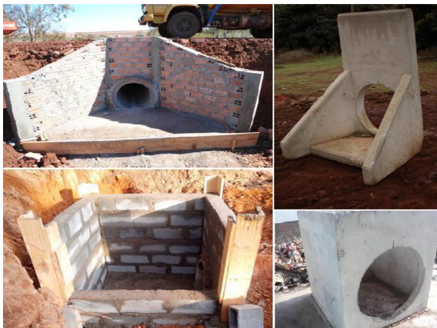
FIGURA 9: Alvenaria em blocos cerâmicos de concreto e pré-moldados.
