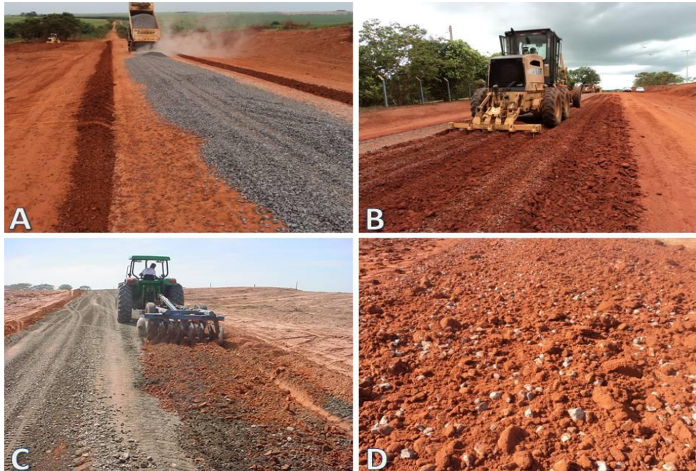
FIGURA 15: Lançamento do material granular (A), Escarificação (B), Incorporação (C), Mistura solo-brita homogênea.
