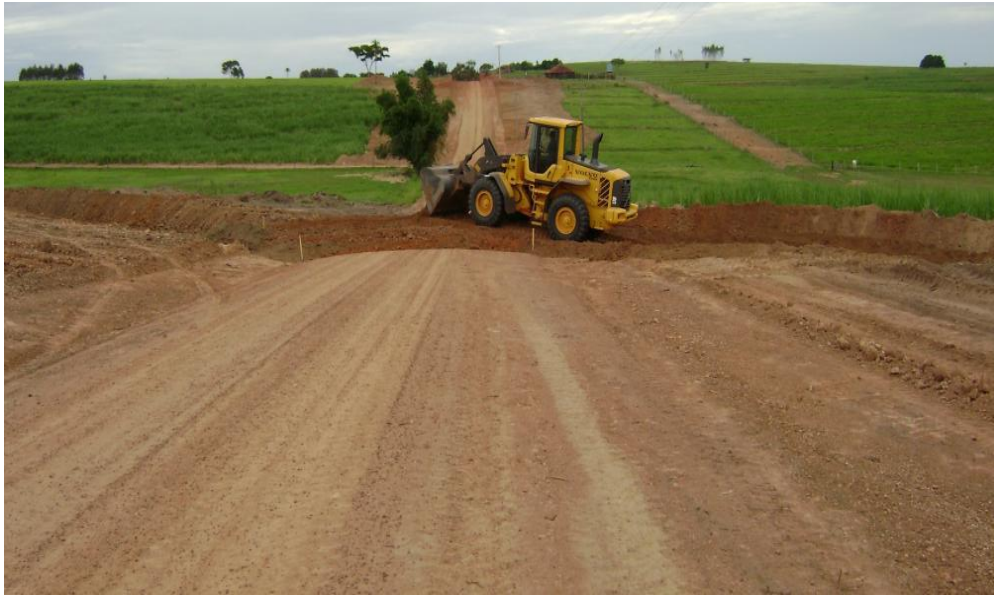
FIGURA 17: Construção de lombada.
