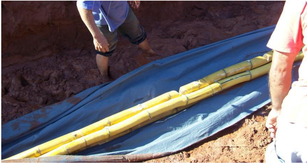
FIGURA 10: Instalação de drenagem profunda com feixes de bambu.
