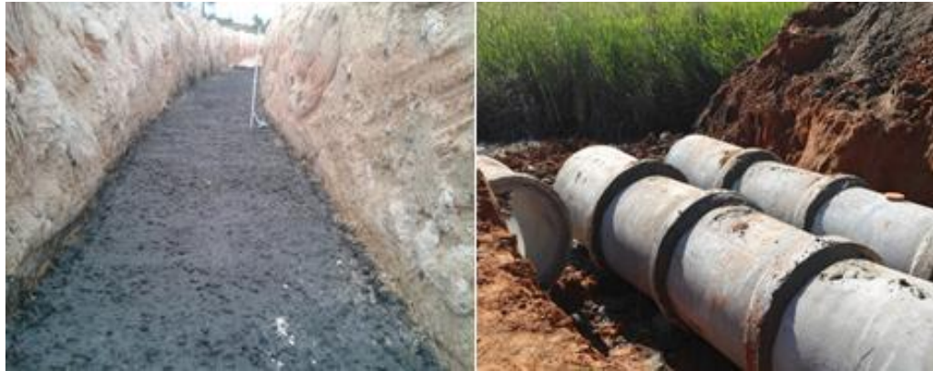
FIGURA 8: Exemplo de berço de concreto e rejuntamento.
