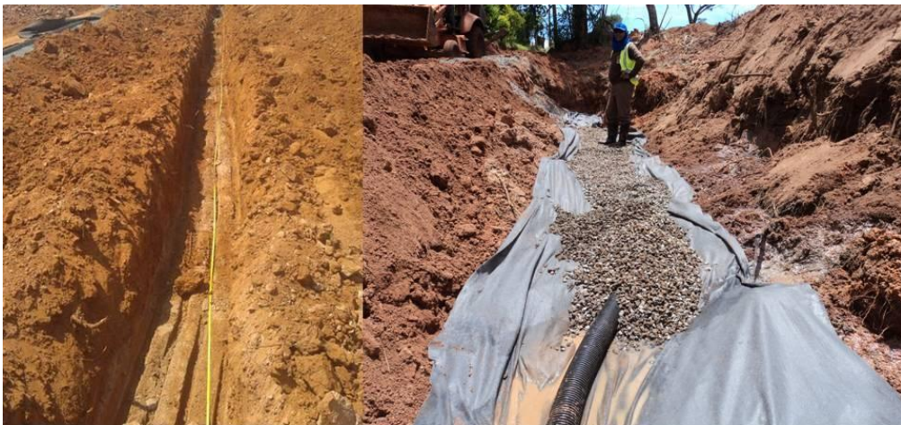
FIGURA 11: Abertura de vala e instalação de drenagem profunda.
