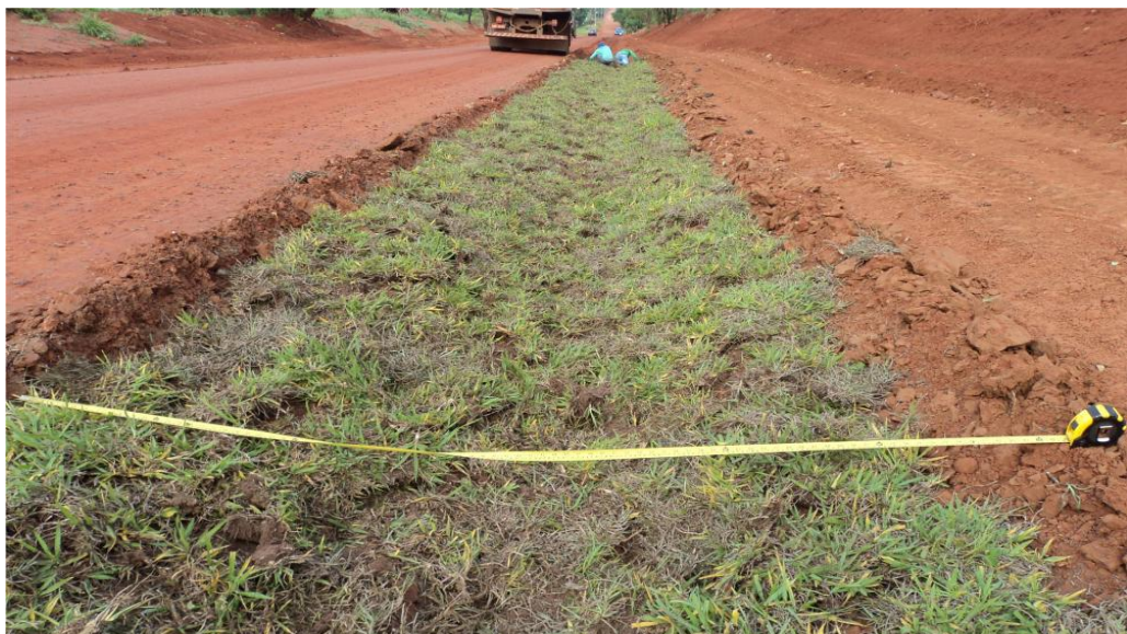
FIGURA 14: Execução de canaletas vegetadas em estrada rural.
