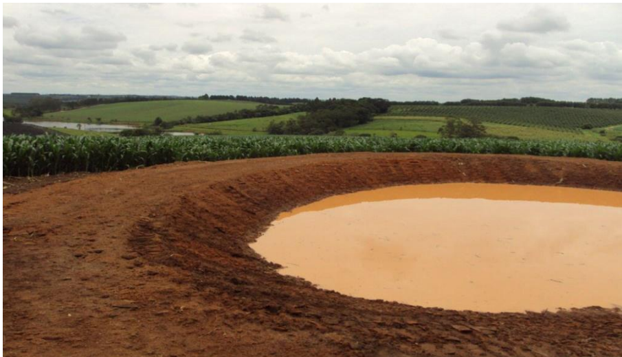
FIGURA 19: Bacia de captação.
