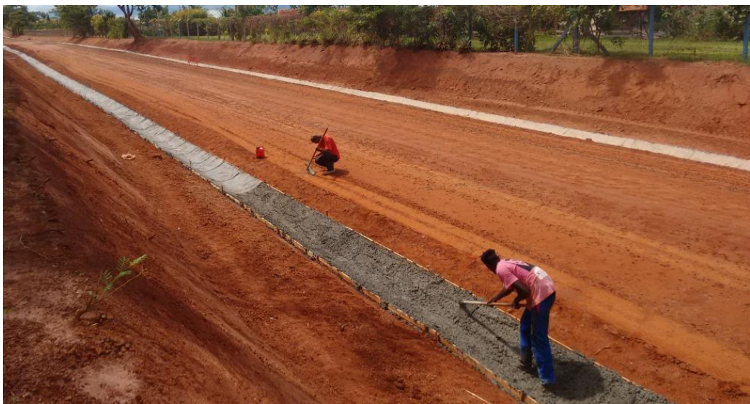
FIGURA 13: Execução de canaletas de concreto em estrada rural.
