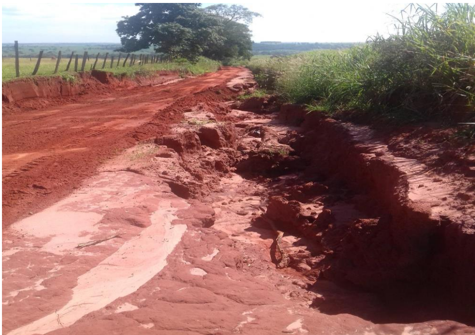
FIGURA 30: Erosão de lateral.
