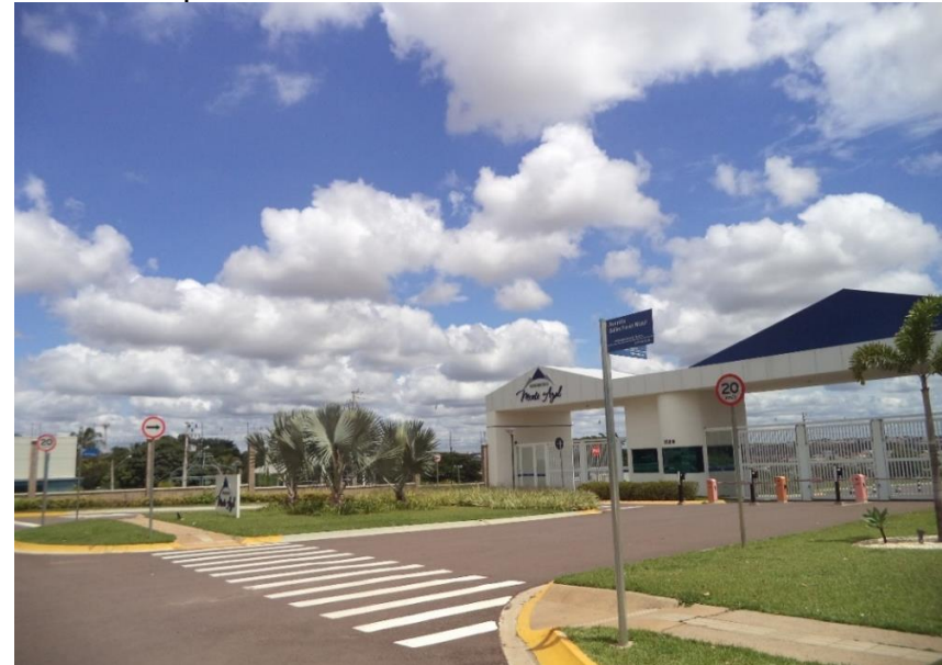
FIGURA 54 - Foto das diversas vias de acesso, para veículos e pedestres.
