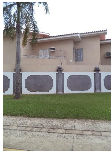
FIGURA 24 - Central Park, possui muro da fachada mais baixos e com detalhes, diferente do muro lateral, com mais de cinco metros de chapisco.
