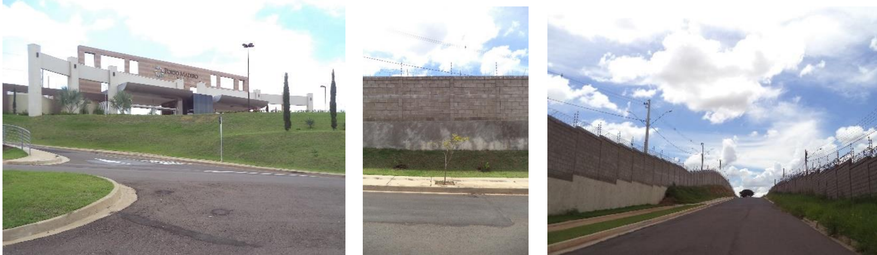
FIGURA 35 - Porto Madero, com muro, cerca elétrica, concertina e talude.
