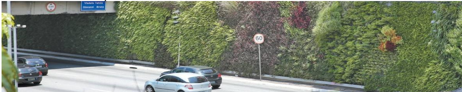
FIGURA 41 - Corredor com jardim vertical.
