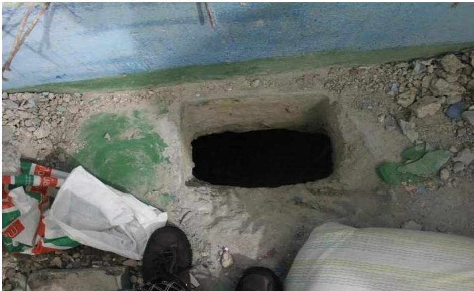
FIGURA 16 – Túnel escavado dentro de uma cela.
