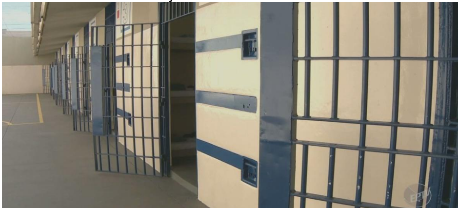
FIGURA 08 – Portas sem automação.
