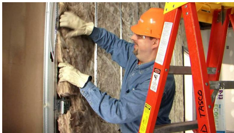
FIGURA 13 : A figura mostra a aplicação de lã de rocha em parede sistema steel frame .
