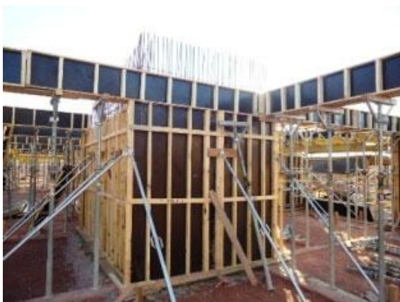
FIGURA 30 : A figura mostra estrutura montada em chapas plastificadas.
