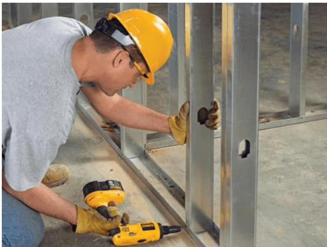
FIGURA 19 : A figura mostra a montagem de painel pelo método stick em construção LSF
