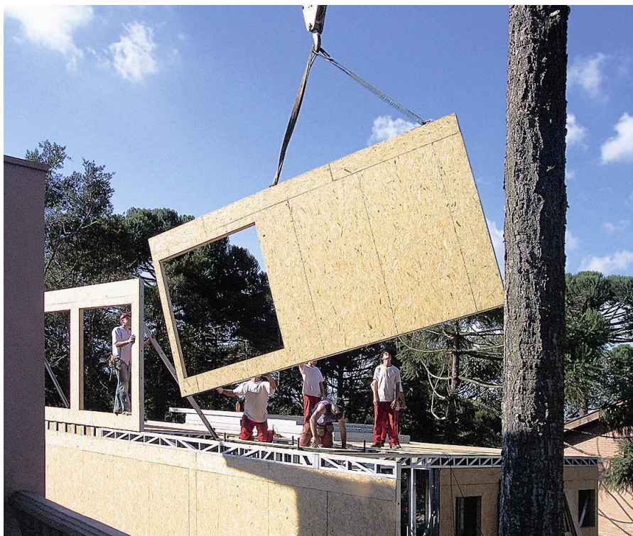
FIGURA 20 : A figura mostra uma edificação utilizando o método do painel
