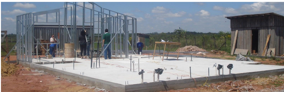
FIGURA 22 : A figura abaixo mostra uma fundação radier com as tubulações hidrossanitárias já assentadas
