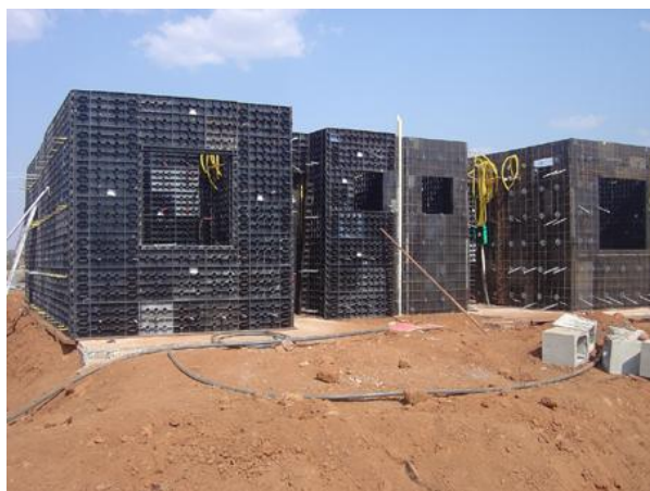
FIGURA 31 : A figura mostra uma construção utilizando as formas plásticas.
