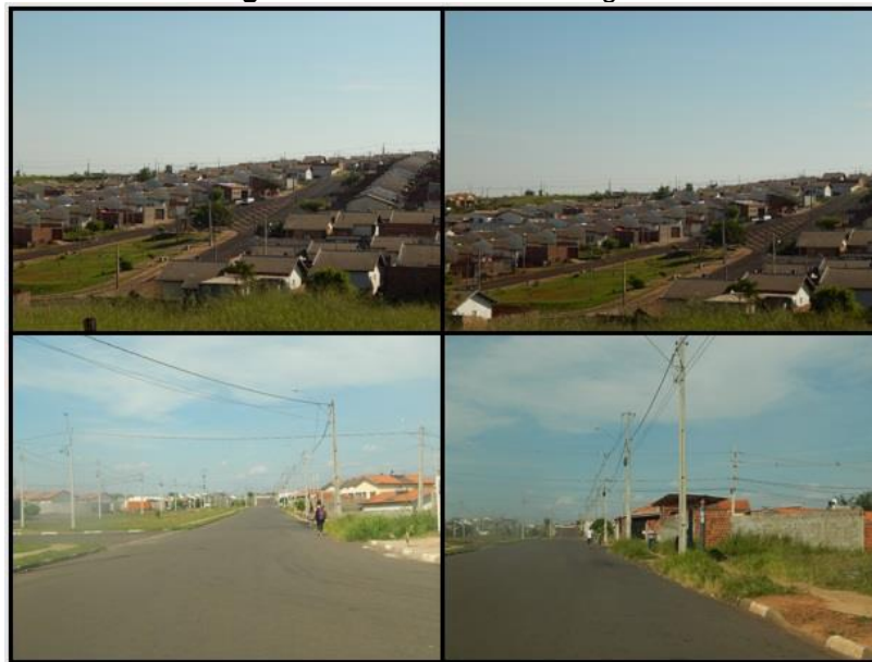
Figura 21: Ausência de Paisagismo
