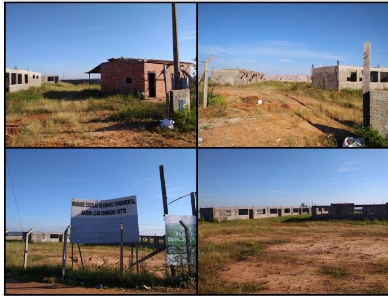
Figura 18: Construção Escola Ensino Médio
