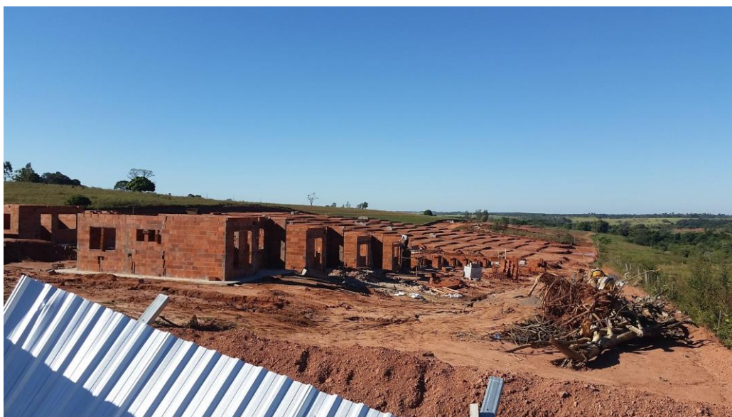
Figura 25: Parede de Blocos Cerâmico em Alvenaria de Amarração
