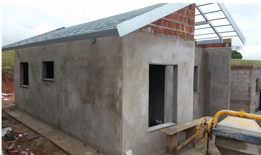
FIGURA 26: Estrutura Metálica do Telhado Pré – moldada
