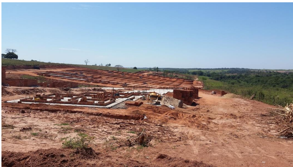
FIGURA 24: Fundação radier e início do assentamento cerâmico
