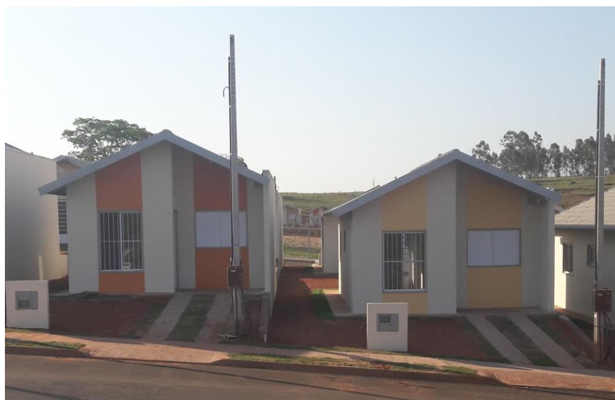
FIGURA 27: Parede da Residência com Divisa do Terreno
