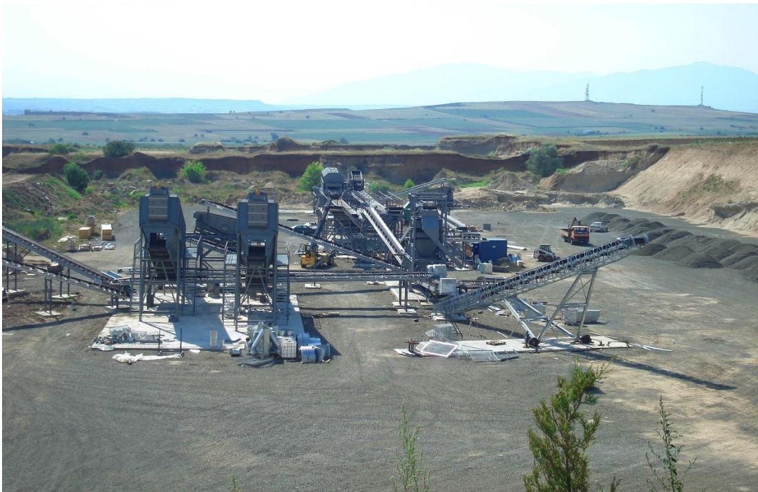
FIGURA 3- Equipamentos de separação de materiais e triagem de RCD
