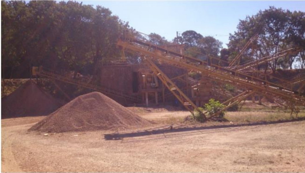
FIGURA 1- Processo de moagem dos RCD na usina de Belo Horizonte
