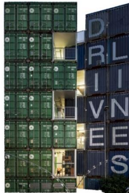
FIGURA 7: FACHADA DOS FUNDOS EDIFÍCIO DRIVELINES.
