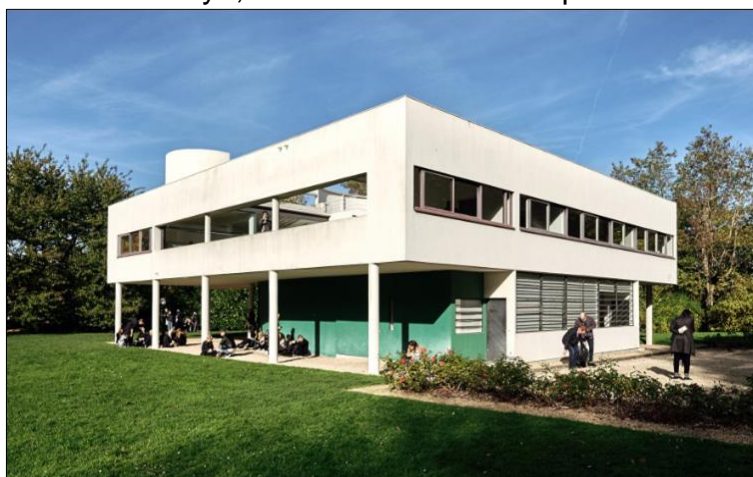
FIGURA 12 - Casa Villa Savoye, Le Corbusier – destaque: Fachada Livre
