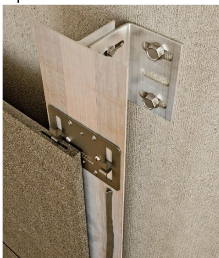
FIGURA 107: Fixação dos painéis cerâmicos
