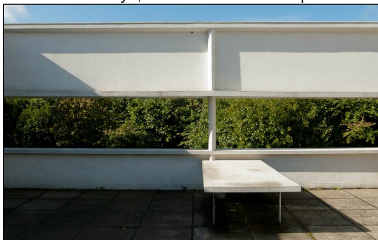
FIGURA 13 - Casa Villa Savoye, Le Corbusier – destaque: Janela em fita
