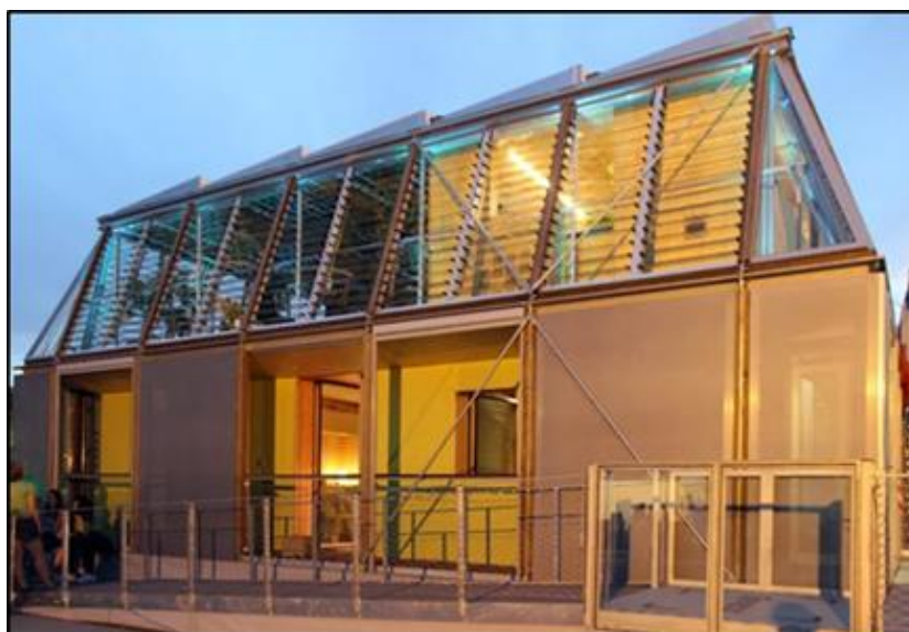
FIGURA 17 - Casa Canopea, SDE, 2012 – fachada com painéis deslizantes
