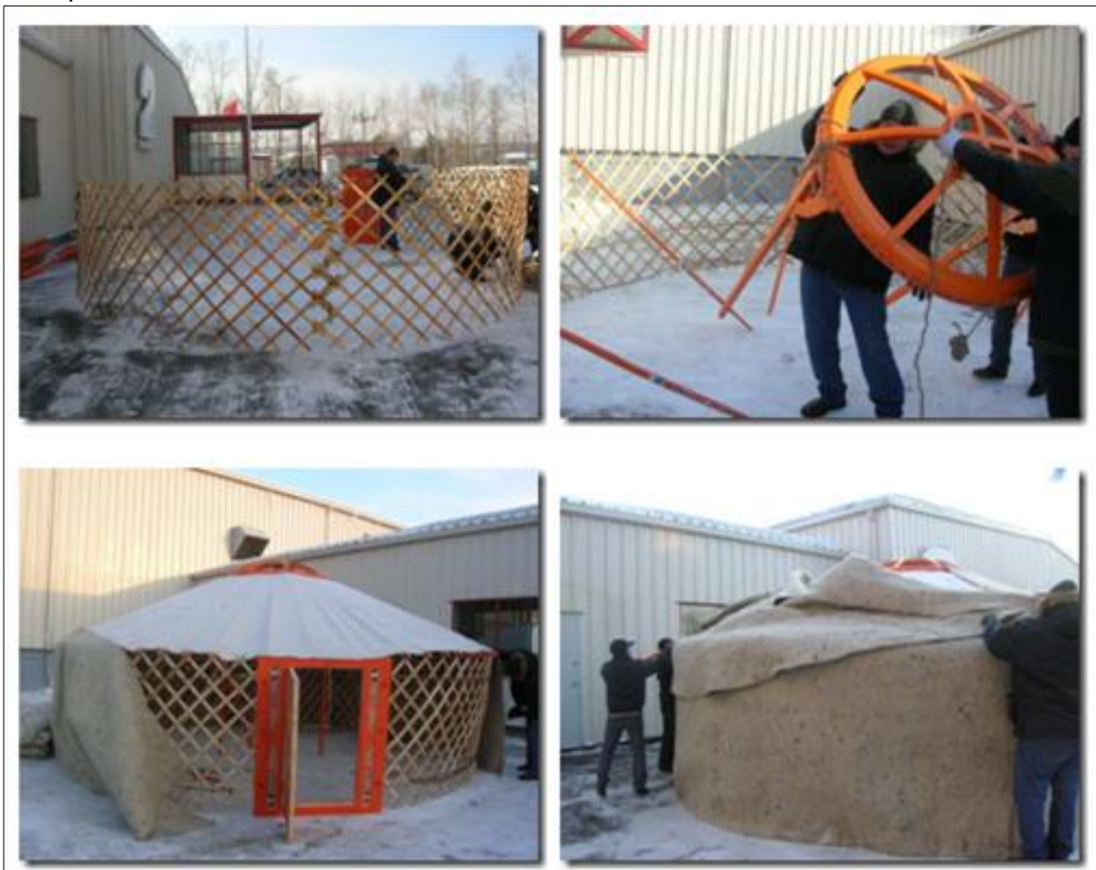
Figura 22 - Etapas da montagem do Yurt – a cobertura varia de acordo com o clima e a época do ano.
