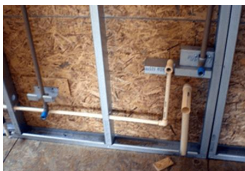
FIGURA 84: Saídas das instalações hidráulicas fixa com perfis metálicos para evitar movimentação
