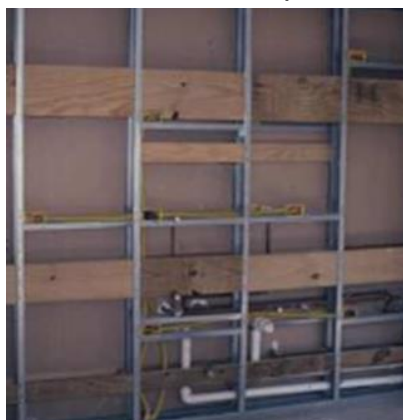
FIGURA 83 : Reforço da parede com madeira para fixação da bancada/pia e sanitário
