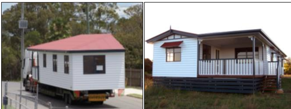
FIGURA 39 - Transporte de uma ( relocatable home ) e a sua locação no terreno
