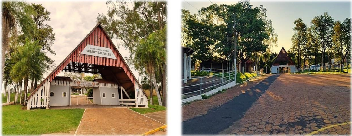
Figura 23 – Vista Externa e Interna do Recinto
