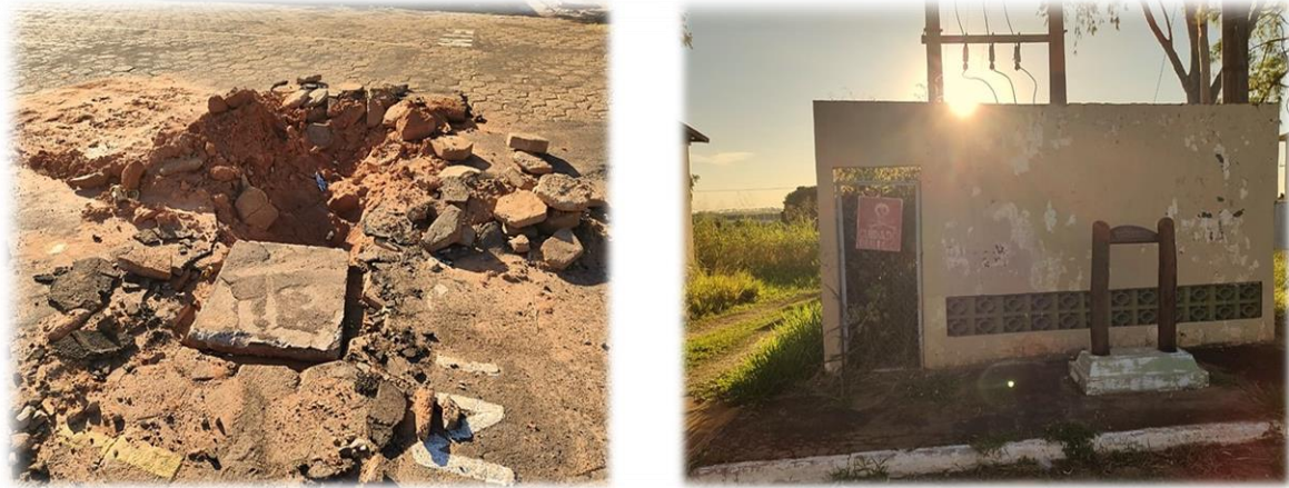
Figura 37 – Via Local e Fonte de Energia
