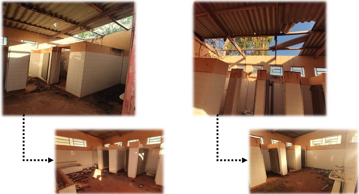
Figura 35 – Banheiro Masculino e Feminino
