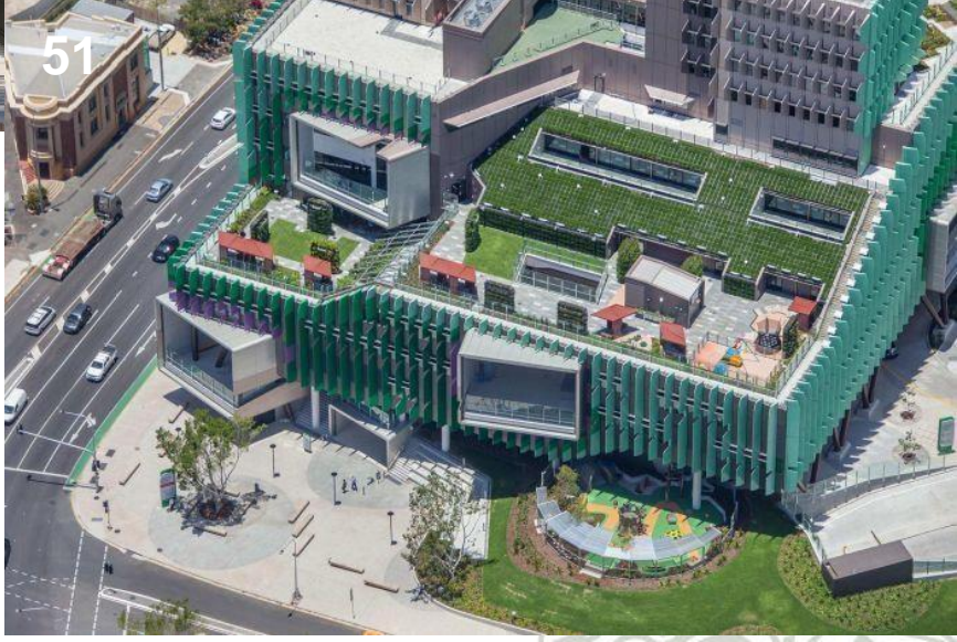
Figura 49, 50 e 51: Fachada, Brises e telhado verde.
