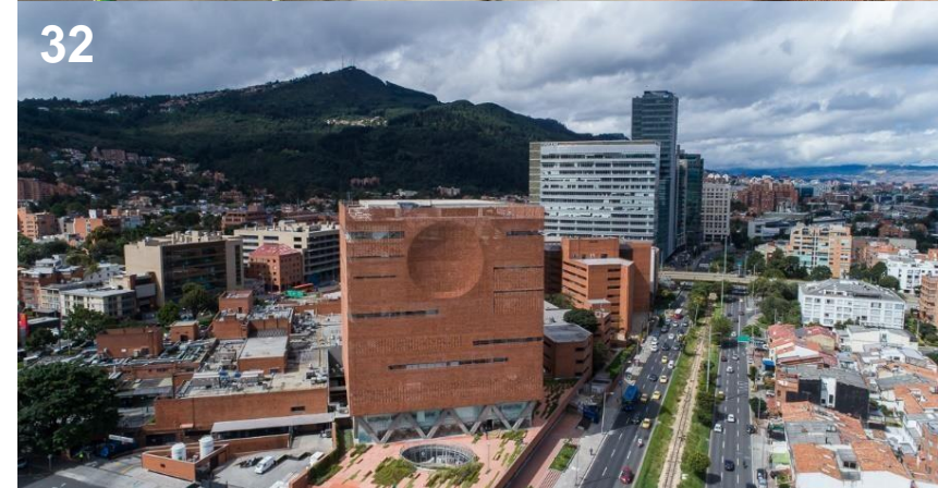
Figura 31,32,34 e 34: Fachada e estrutura dos bloco em tijolo
