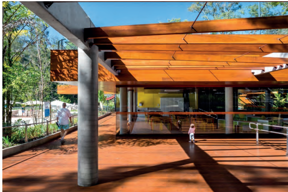
Fig. 16 – Vista do edifício mostrando ambiente interno com acesso visual para o externo.
