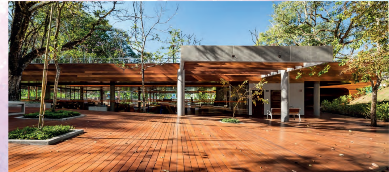
Fig. 14 – Vista do edifício mostrando a materialidade.
