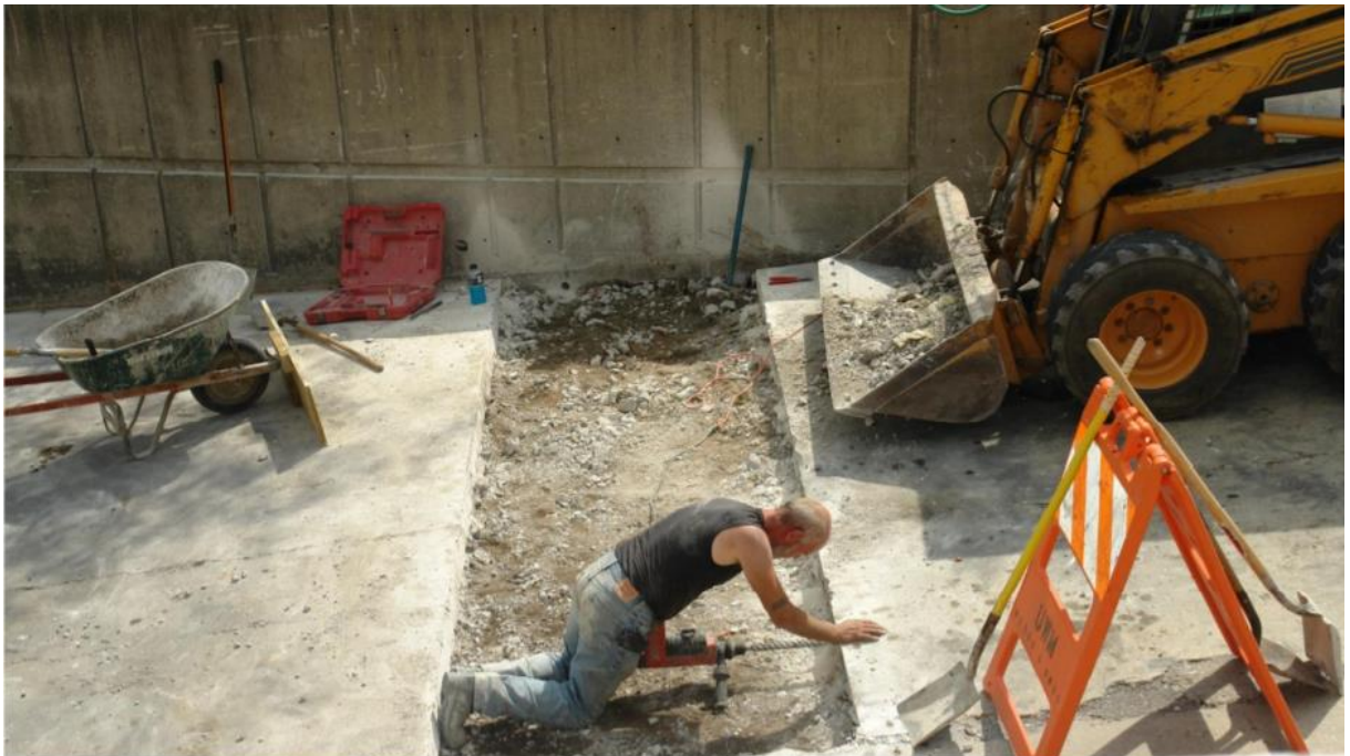
FIGURA 18 – Local da inserção da laje após a retirada do material deteriorado.
