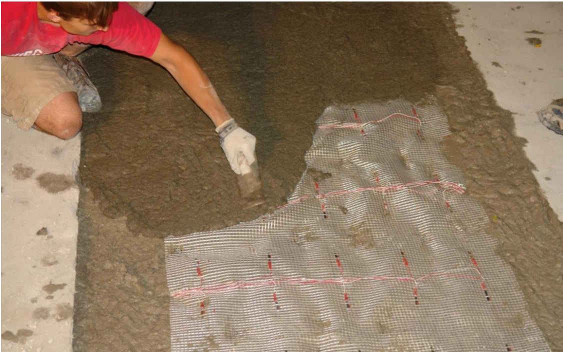
FIGURA 20 – Dispondo material condutor sobre a malha de fibra PVA com eletrodos.
