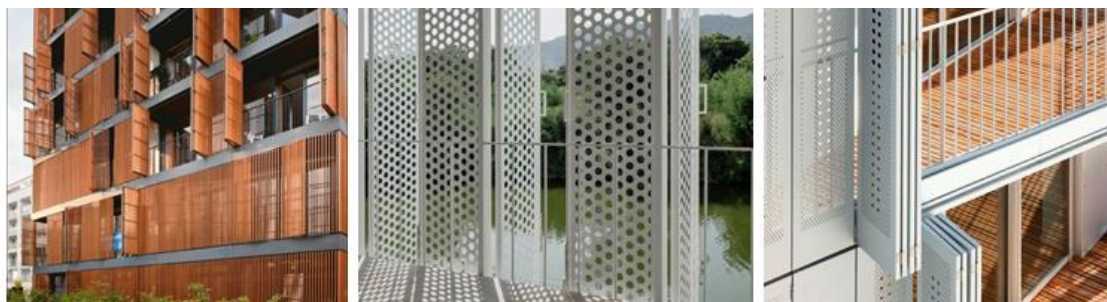
Figura 83 – Fachadas com persianas em aço.
