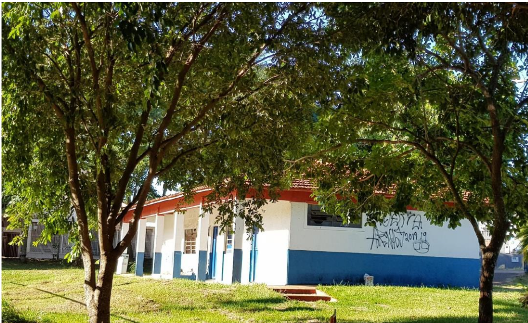
Figura 32: Vista dos sanitários – Parque das Andorinhas Fonte: Renata Fernandes S. Nardo – maio 2020
