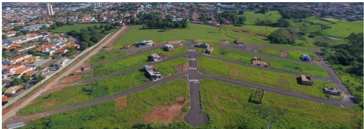
Figura 46 – Pavimentação asfáltica e sinalização viária
