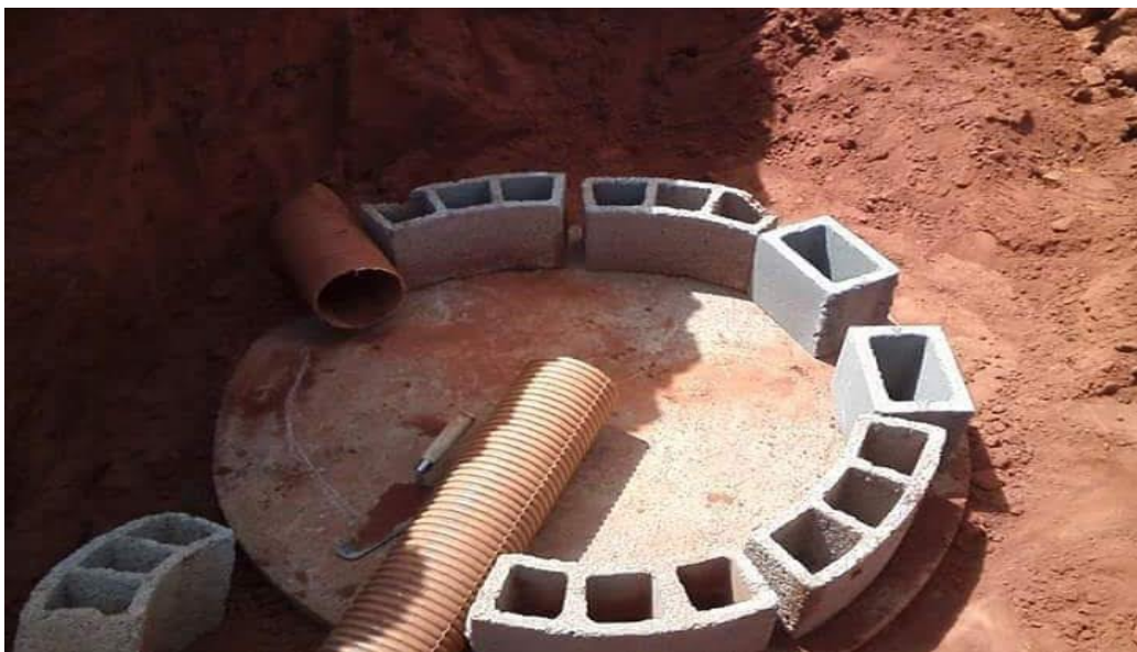
Figura 32 – Execução de um poço de visita
