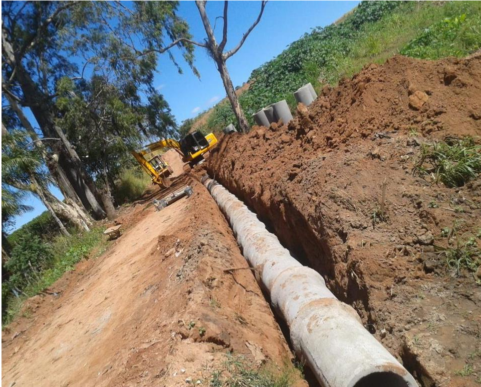
Figura 20 – Execução da rede de galerias de águas pluviais in loco
