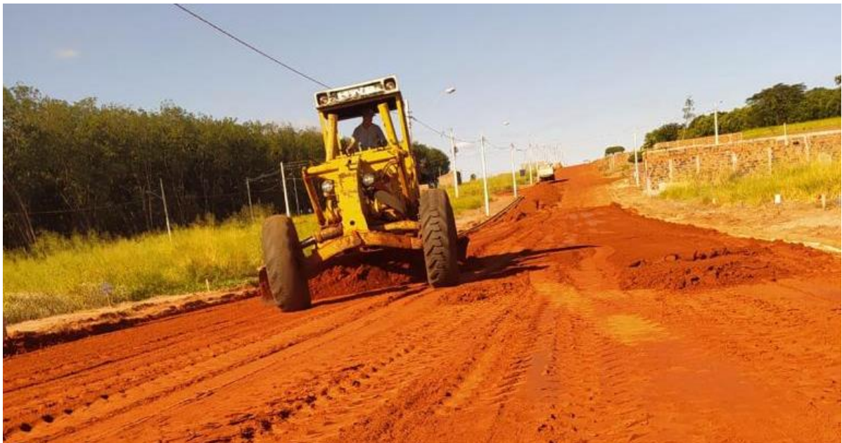
Figura 10 – Preparo da base utilizando uma motoniveladora Patrol
