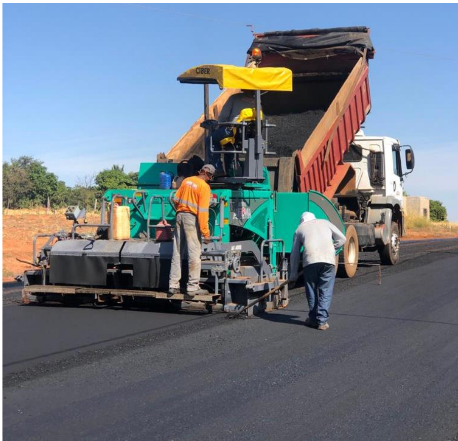
Figura 43 – Execução da Pavimentação em CBUQ
