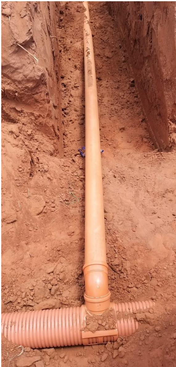
Figura 30 – Execução da rede coletora de esgoto e ramal de interligação domiciliar
