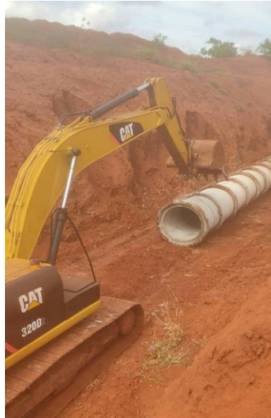
Figura 18 – Execução da rede de galerias de águas pluviais in loco
