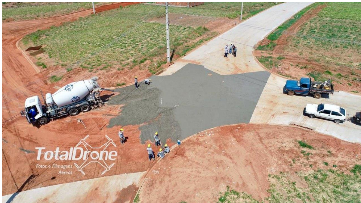
Figura 45 – Execução da pavimentação rígida de concreto
