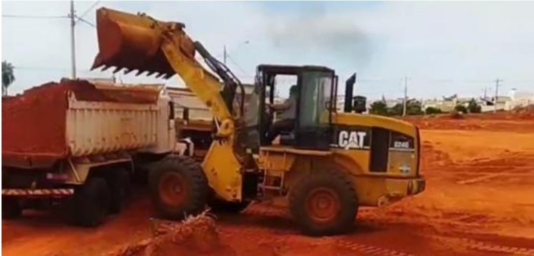
Figura 9 – Execução dos serviços de terraplenagem in loco utilizando uma escavadeira e um caminhão basculante.
