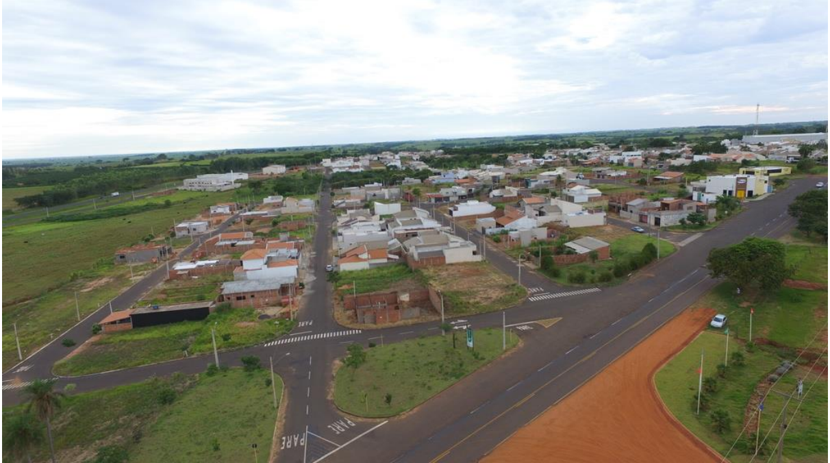
Figura 50 – Vista aérea da área loteada após a execução das obras de infraestrutura
