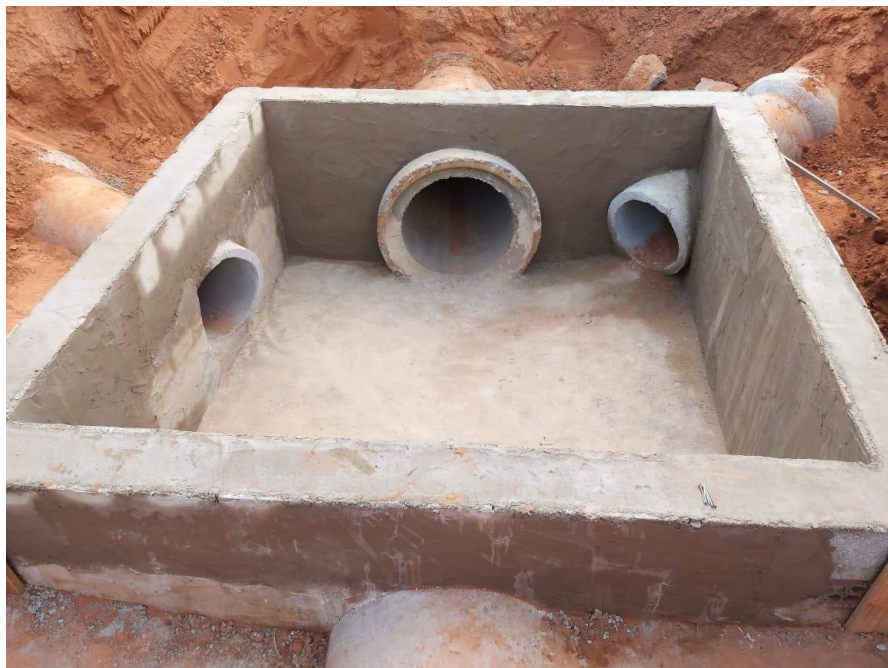
Figura 17 – Execução de um poço de visita de alvenaria in loco
