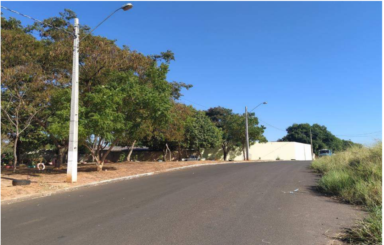
Figura 34 - Vista do entorno com a praça
