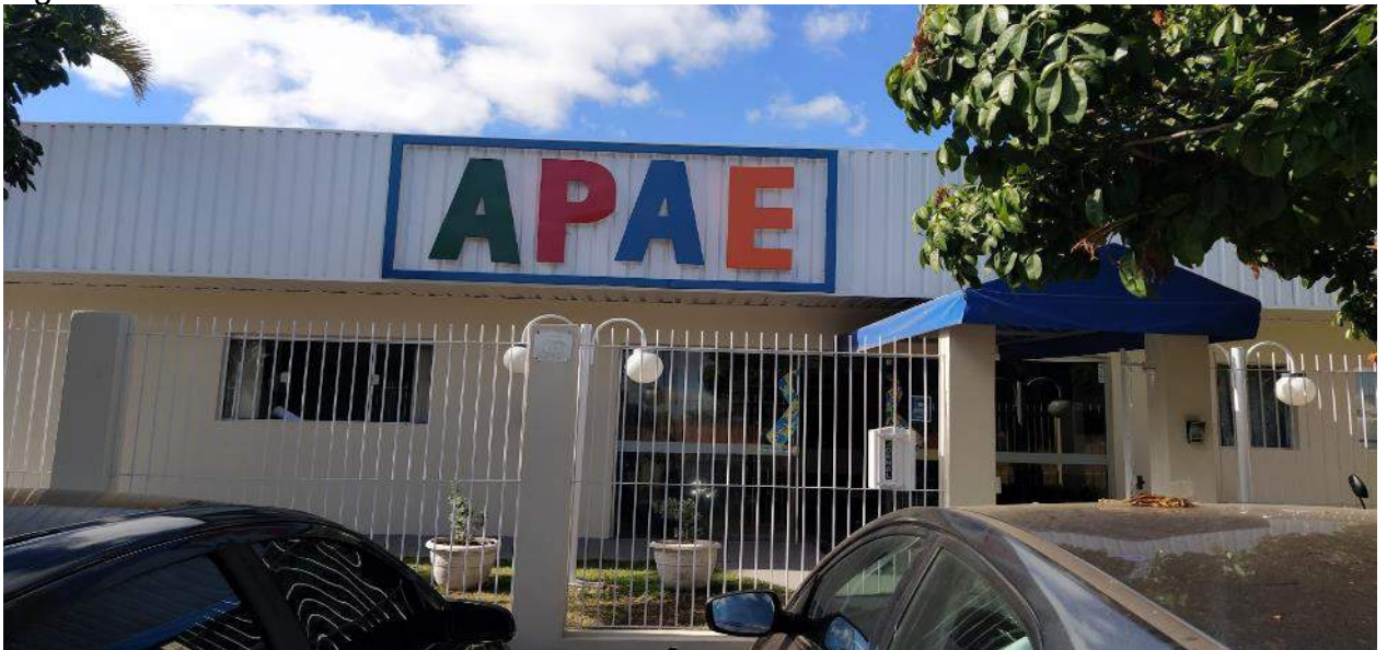
Figura 6 - Fachada do edifício
