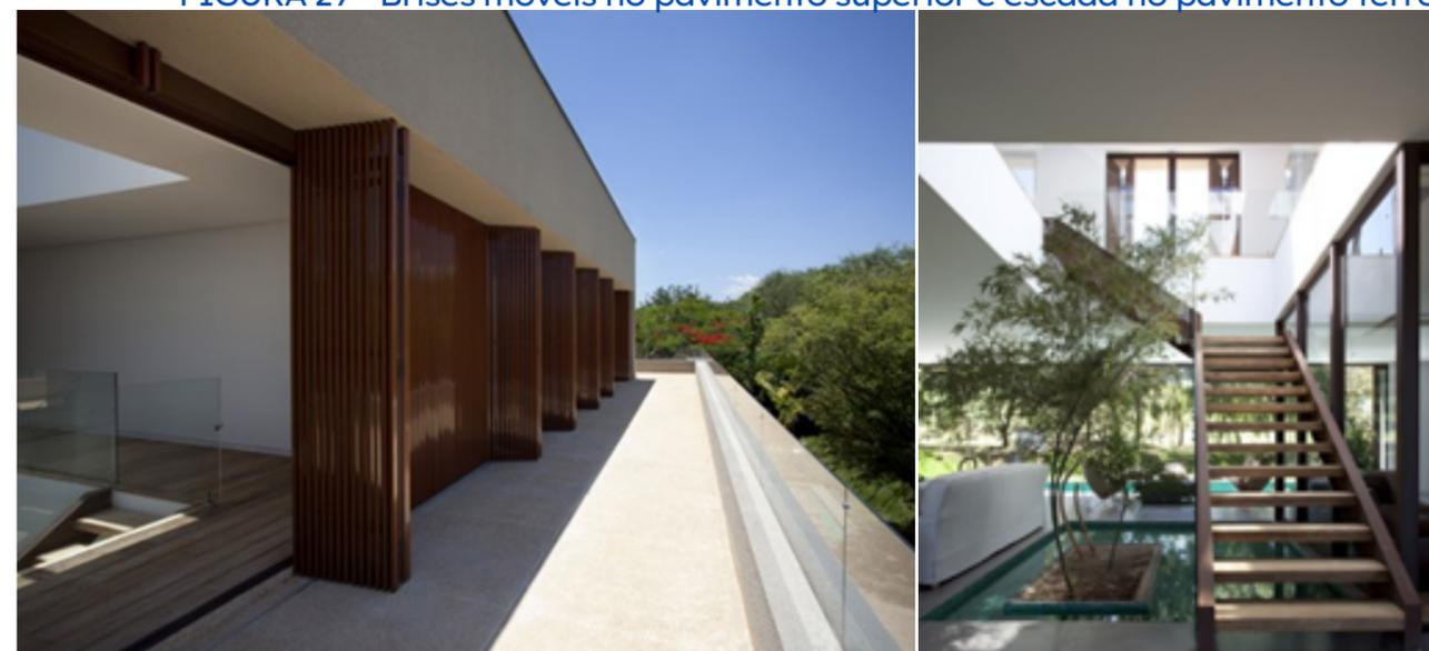
FIGURA 29 – Brises móveis no pavimento superior e escada no pavimento térreo
