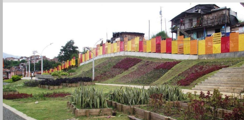
Imagem 3 – Recuperação do trecho experimental 1 da encosta ocidental do Morro Moravia Fonte: (FERNANDES, 2012)
