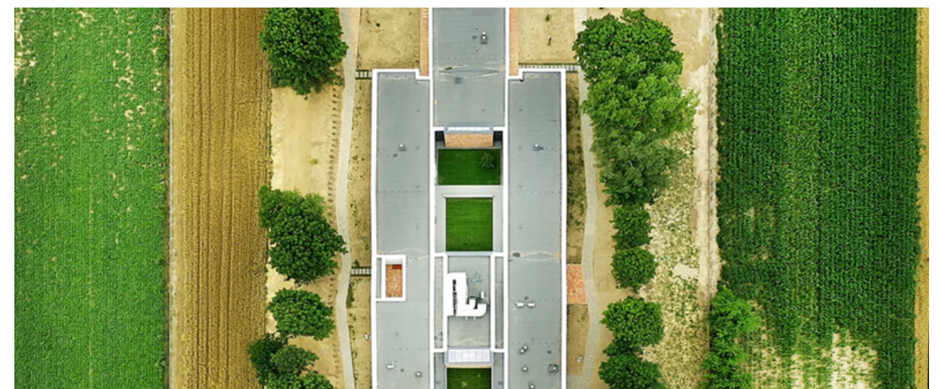
FIGURA 24: VISTA SUPERIOR - HABITAÇÃO SOCIAL EM JANKOWICE
