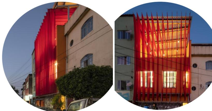
**Fachada:** Fachada e cobertura com brises têxteis confeccionados pela equipe do REMEXE, auxiliando na circulação interna da edificação e redução da insolação direta, e uma forma de integrar a comunidade no processo. A fachada se destaca nas construções do entorno, ao mesmo tempo que se camufla ao utilizar tons similares aos mais presentes nas fachadas circunvizinhas.
