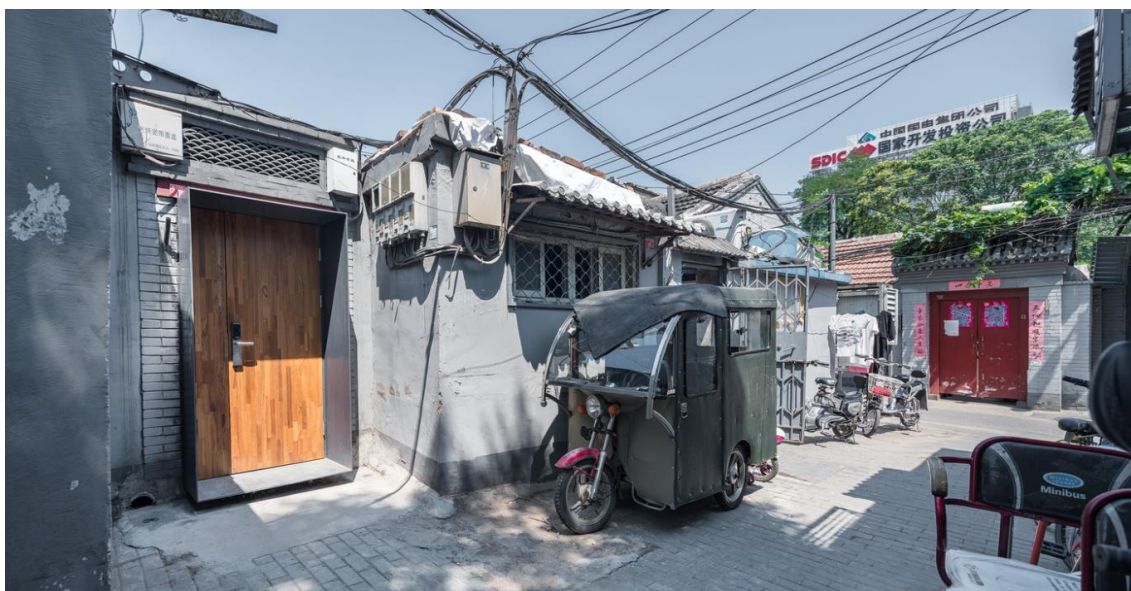
Figura 21: Porta de acesso à residência.
