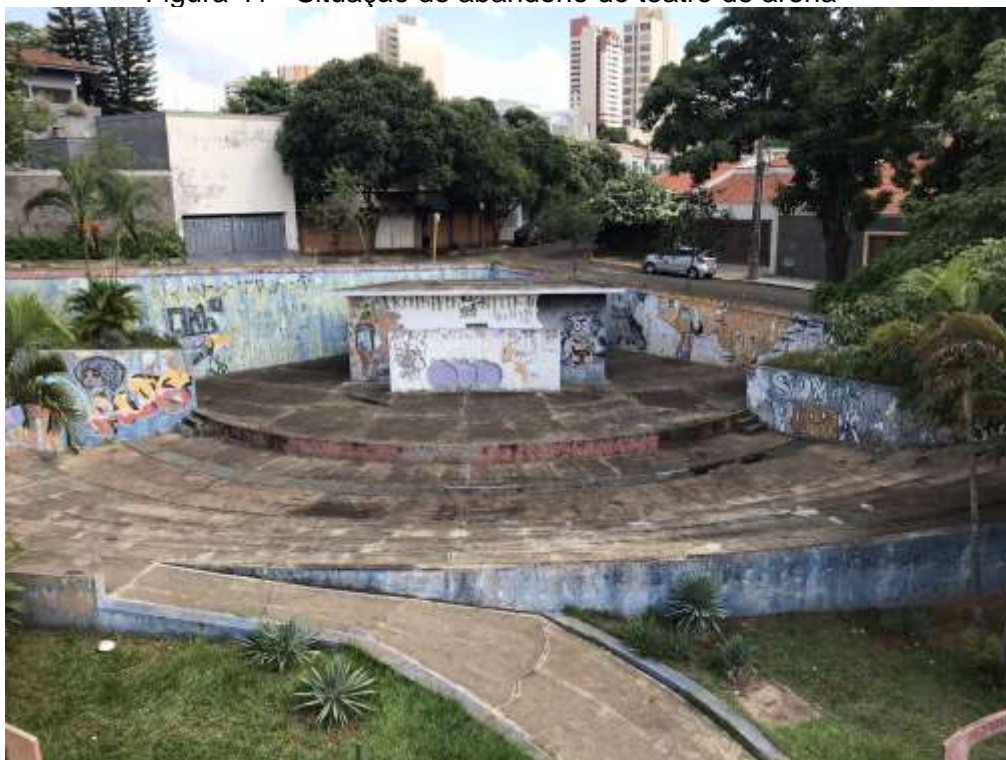
Figura 41 - Situação de abandono do teatro de arena
