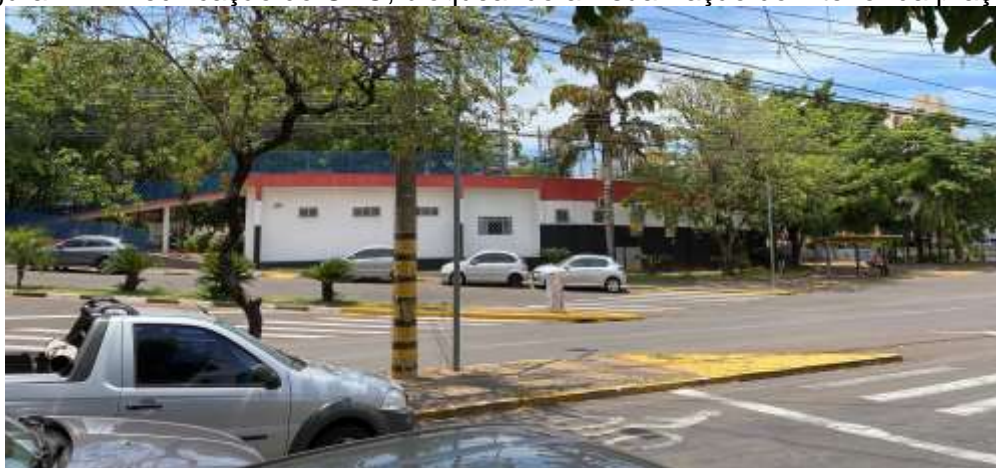
Figura 42 - A edificação do CEO, bloqueando a visualização do interior da praça
