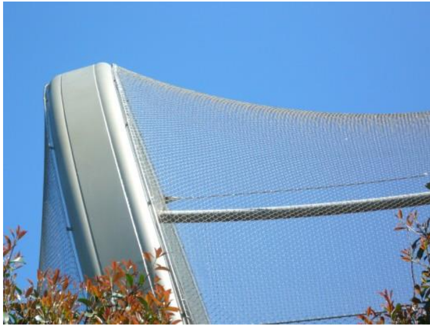
Figura 10 - fechamento "invisível" dos viveiros em malha de aço inoxidável com 25mm 2 de trama.
