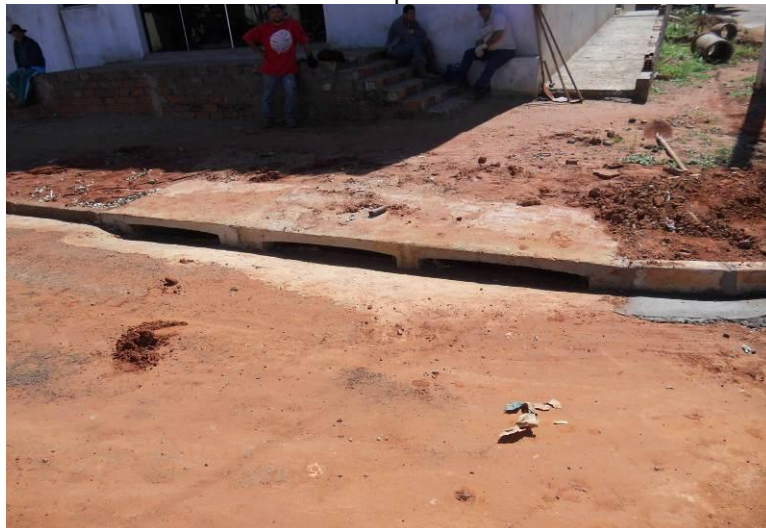
FIGURA 10 – Boca de lobo múltipla
