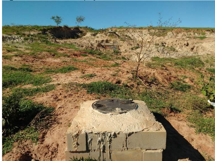
Figura 12 – Acesso ao poço de visita
