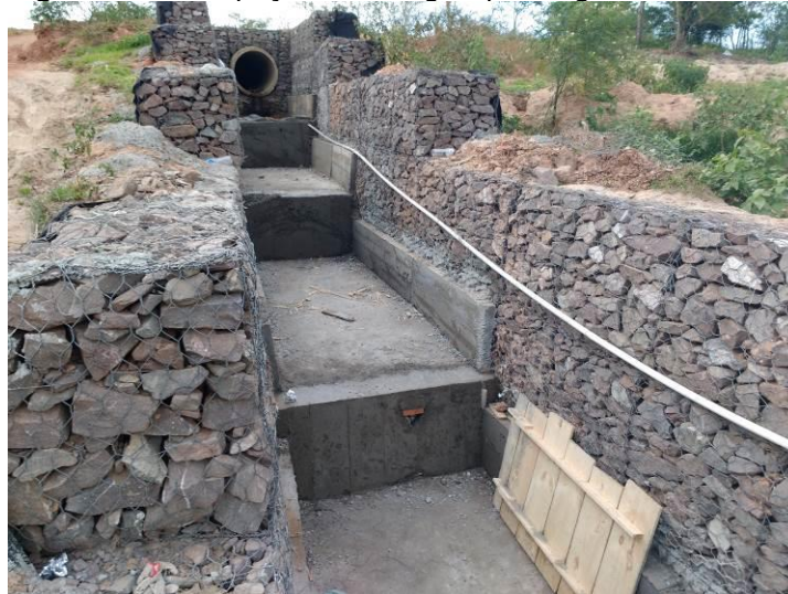
Figura 14 – Dissipação de energia tipo “Degrau”
