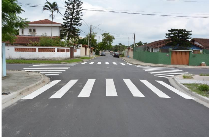
FIGURA 6 – Rua pavimentada, guias e sarjetas
