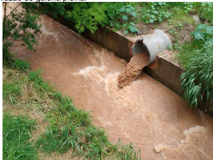
Figura 15 – Canal revestido de concreto com despejo de vazão de galeria pluvial
