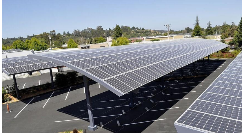
Figura 2- Garagem com cobertura de placas solares
