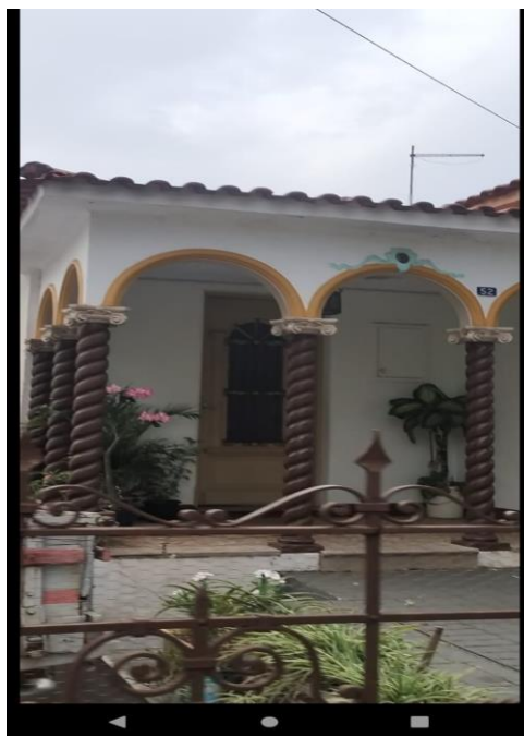
Figura 6 – Fachada da Residência do Estilo Missões em Álvares Machado-SP
