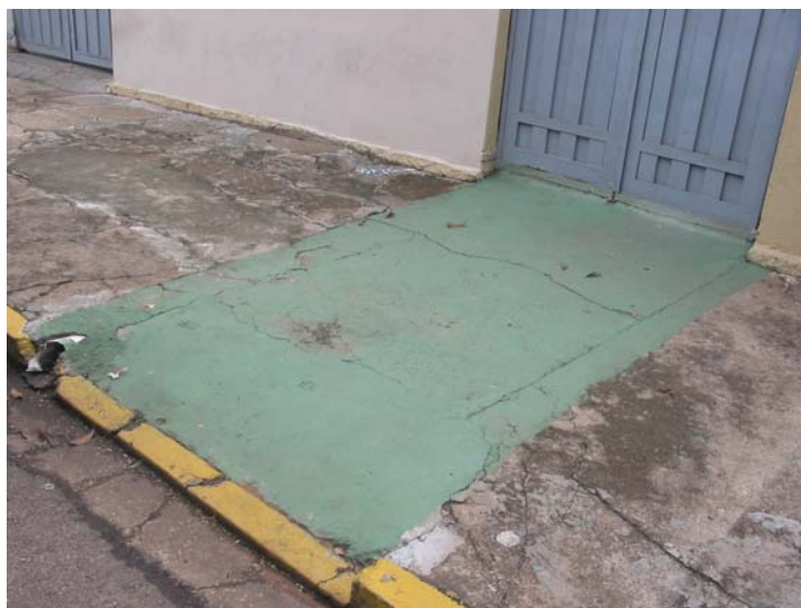
Foto I - Portão de Entrada - Secretaria
