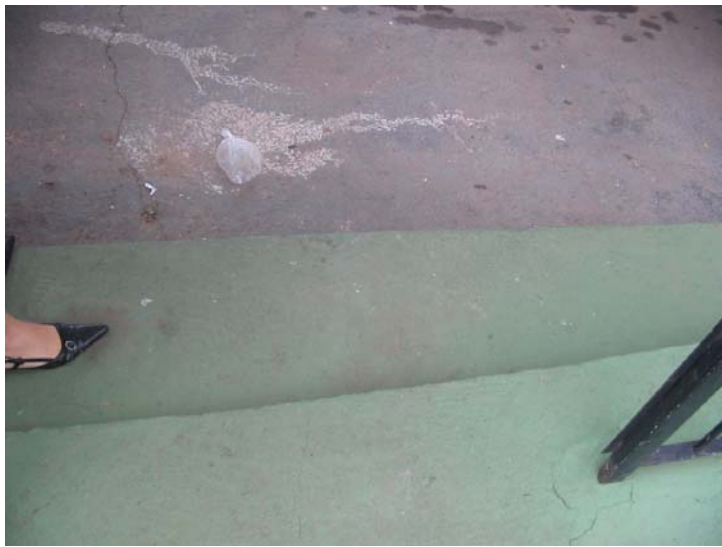
Foto IV - Acesso ao pátio
