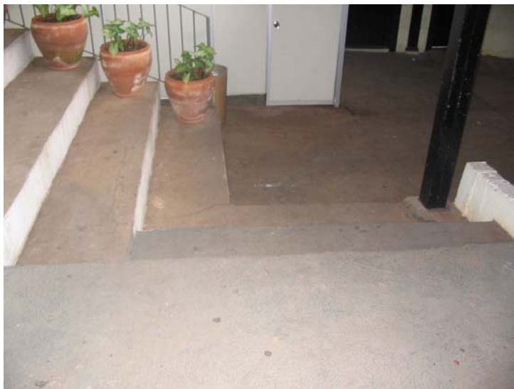
Foto V - Acesso ao pátio
