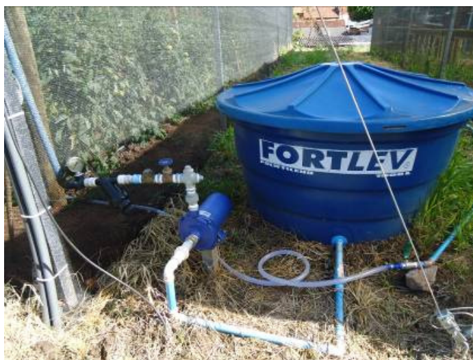
Figura 1: Sistema de irrigação e bombeamento instalado na Fatec de Presidente Prudente.
