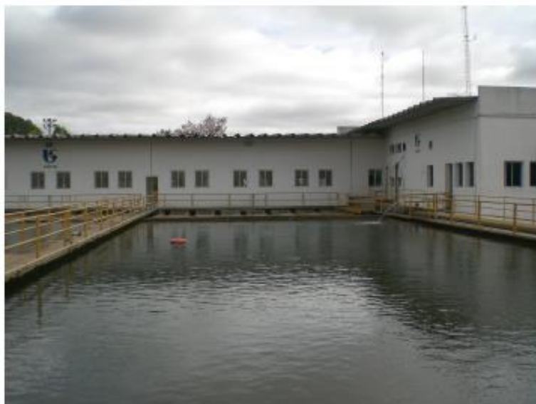
FIGURA 4 - Vista de um dos decantadores da ETA de Presidente Prudente.
