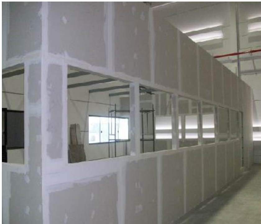
Figura 4 - Divisórias de Gesso Acartonado.
