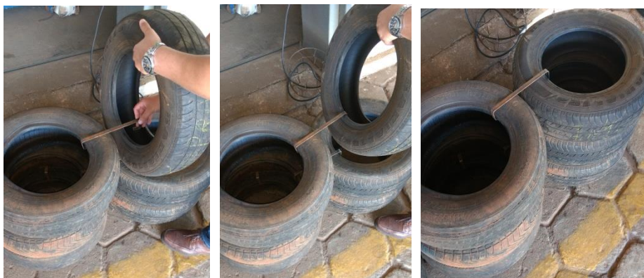
Figura 5: Travamentos Dos Pneus Reciclados Utilizando A Técnica De Clipagem.
