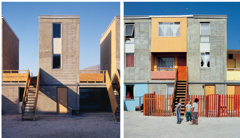
Figura 1. Habitação Social Quinta Monroy. Na primeira foto é a unidade habitacional quando é entregue aos moradores e na segunda foto é a unidade com a autoconstrução realizada pelo morador.
