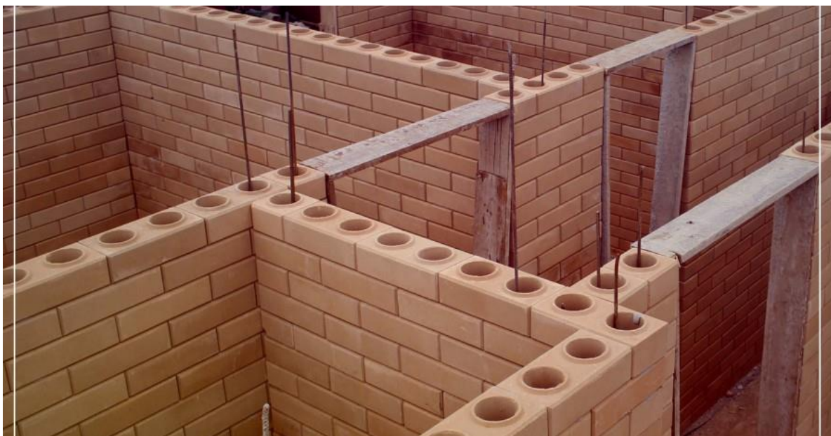
Figura 03: Armamento de pilares embutido no bloco de solo-cimento
