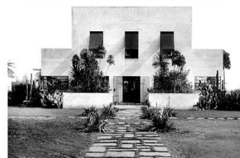
FIGURA 6: Casa da rua Santa Cruz
