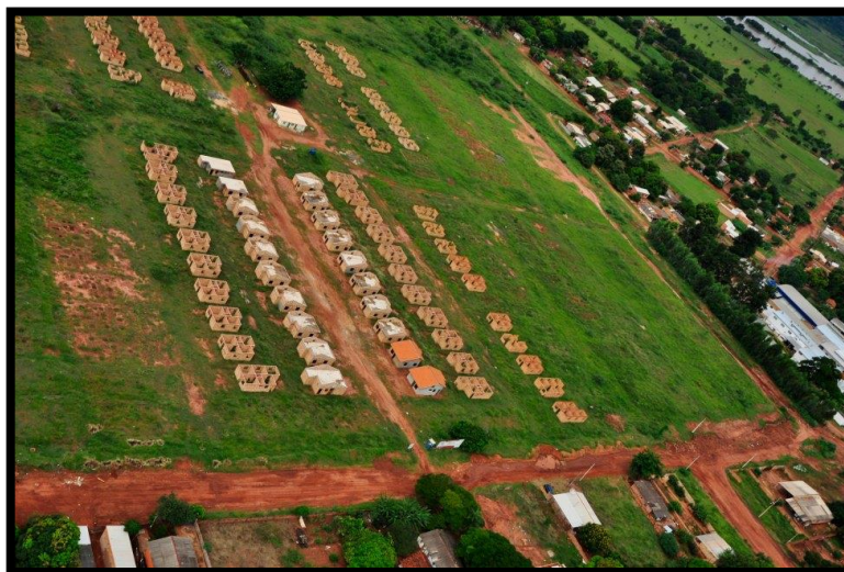
Figura 10: Construção das moradias
