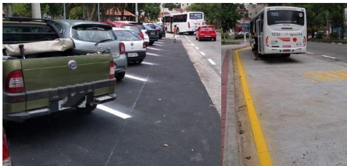
Figura 06. Antes e depois da construção do bolsão, Av. John Kennedy
