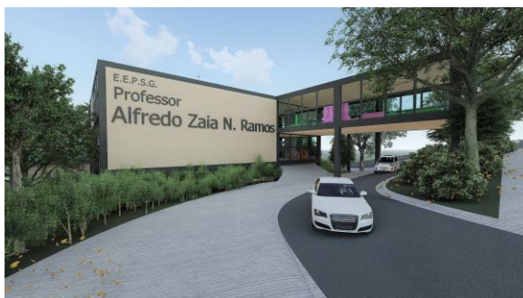
Figura 10. Porte Cochère na entrada principal da escola
