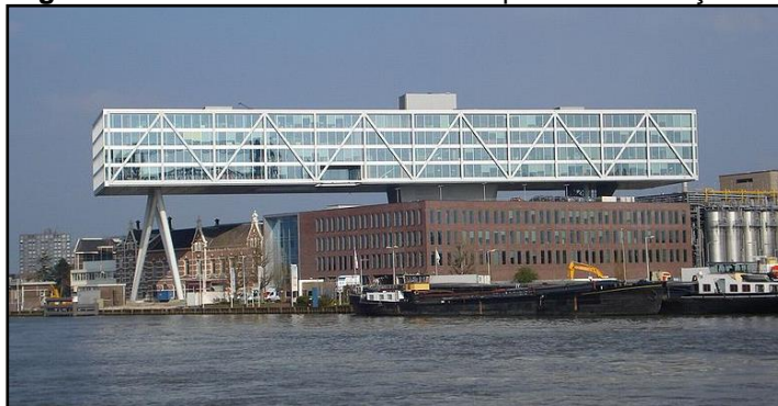
Figura 2. Sistema estrutural metálico plano com treliças.
