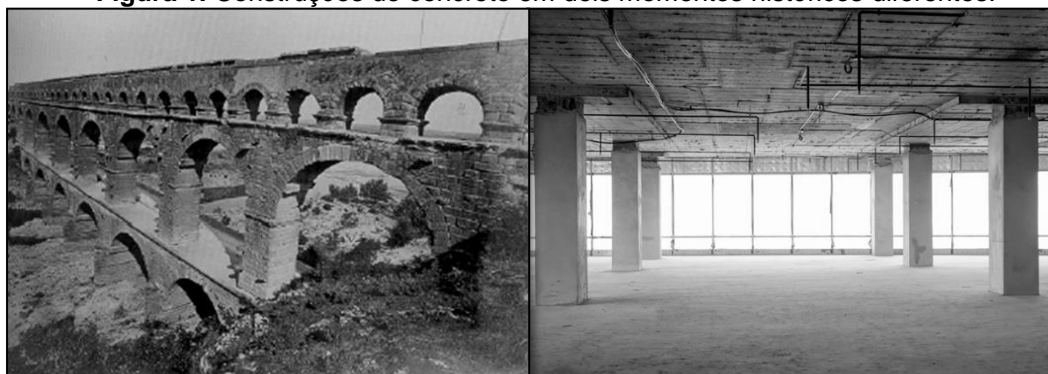
Figura 1. Construções de concreto em dois momentos históricos diferentes.
