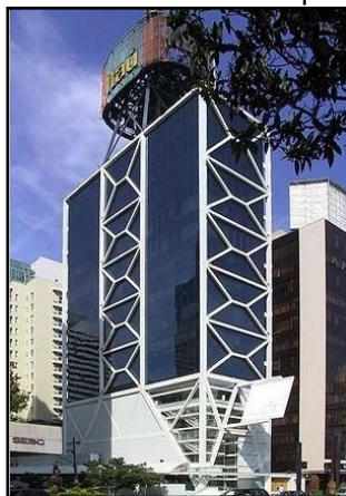
Figura 3. Sistema estrutural metálico plano aporticado.
