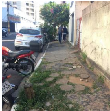
Figura 1 – Buracos e altura livre < 2,10 m
