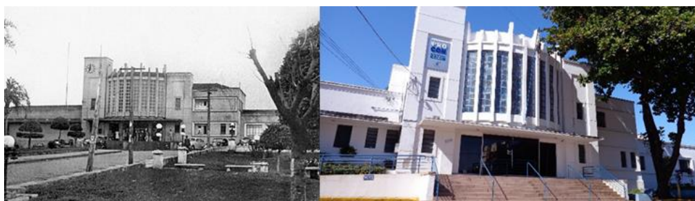
Figura 5: Edifício da Estação Ferroviária antes e depois.
